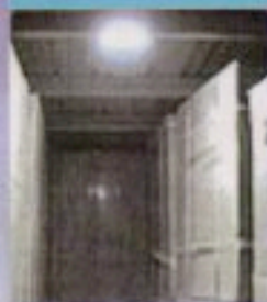
倉庫の照明に
